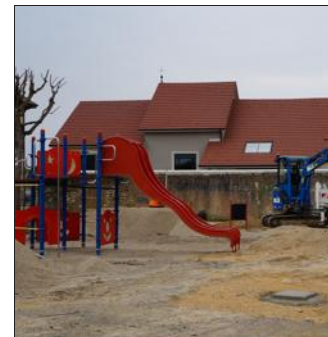
L'entreprise Id Verde est en charge du chantier.
